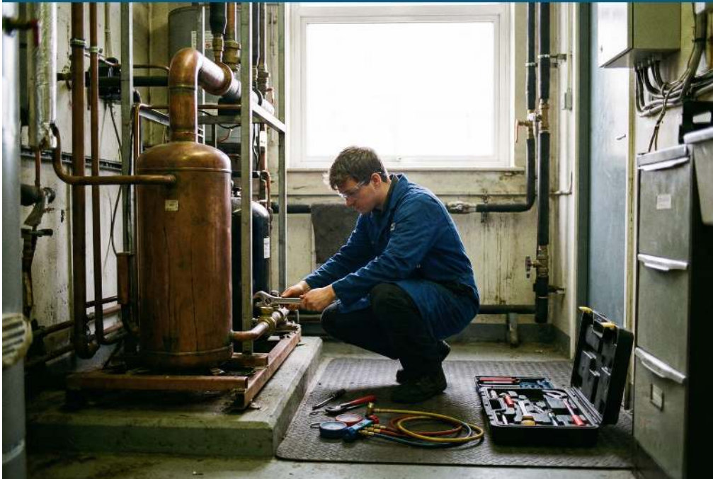
Installation de vannes d'isolement, indispensable pour la maintenance des circuits frigorifiques
